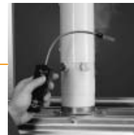
Rückstauprüfung mit testo 317
