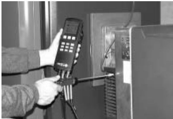
Abb. 13: Messen der Verbrennungslufttemperatur
