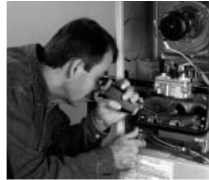
Abb. 28: Wartung und Inspektion einer Heizungsanlage ohne Demontage mit dem testo 318
